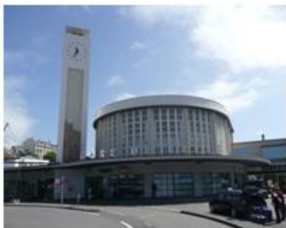
Bâtiment des voyageurs de la gare ferroviaire de Brest (19 septembre 2018)
